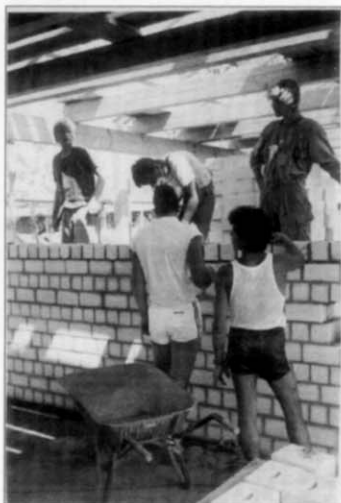
Der neue Jugendtreff im Rohbau.
